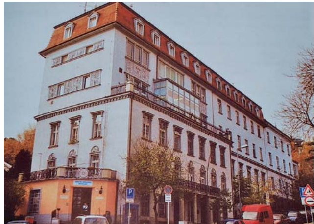
Obr. 18.1.2. Historická budova Ortopedickej kliniky na Hlbokej ulici v Bratislave.
